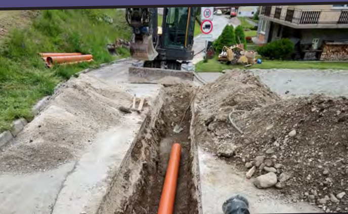
Izgradnja sekundarne kanalizacije v aglomeraciji Vič - V predmetni aglomeraciji Vič je sedaj dodatno priključenih 232 PE (vsi iz gospodinjstva). Tako je na tem področju priključenih vsaj 98% PE na javno gospodarsko infrastrukturo odvajanja in ustreznega čiščenja odpadnih voda. Vrednost izgradnje projekta v znesku 690.585,14 € je bila sofinancirana v višini 87,55 % s strani Evropske unije in pripadajoče udeležbe Republike Slovenije, in turizem v višini 100.000 €. (KM)
