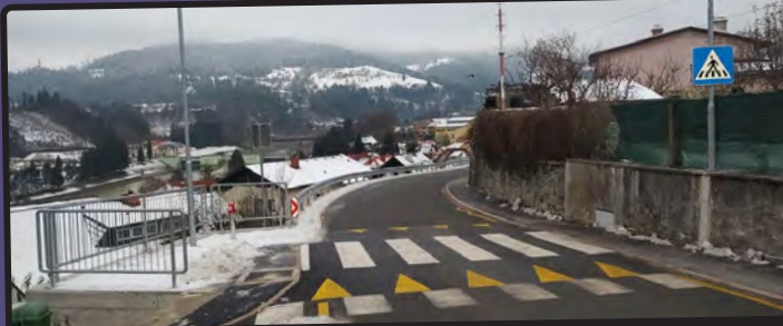
Cesta na Podgrad s pešpotjo - zaključena je bila obnova odseka lokalne ceste Dravograd–Ojstrica–Junčko–Pernice v naselju Pod gradom v dolžini dobrih 600 metrov. Vrednost investicije je znašala 830.197,72 €. (MS)
